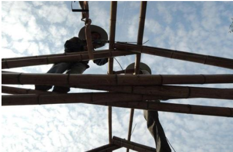
圖 4.1 工人師傅安裝屋架與檁條
